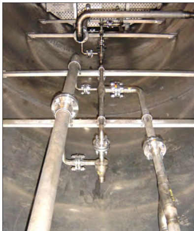
Tore OVD Installation
