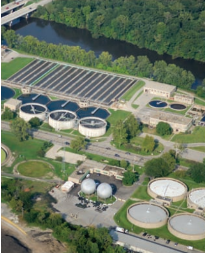
Eau & eau usée
